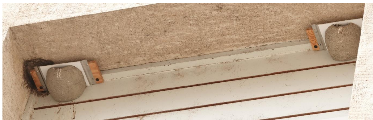
Figure 2 : Nichoirs artificiels d'hirondelle de fenêtre installés sur le bâtiment de la restauration, façade nord
